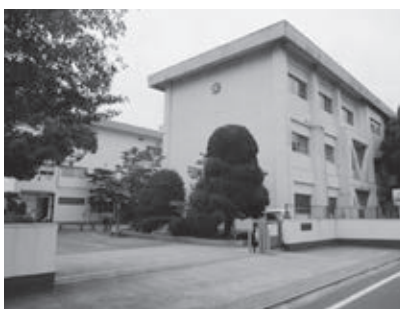
教室不足を補うため、南舎を建設(住吉小学校)
