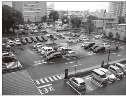
修繕し、排水機能の向上を (市役所平面駐車場)
