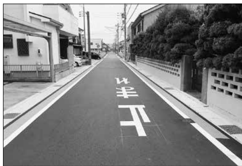
側溝整備の早期完了を
