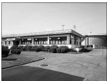
災害復旧の要となる配水場
