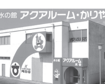
水質や衛生に関する管理工程も見学できる (西境町：浄水管理事務所内)
