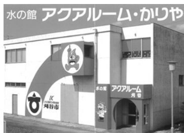
水質や衛生に関する管理工程も見学できる (西境町：浄水管理事務所内)
