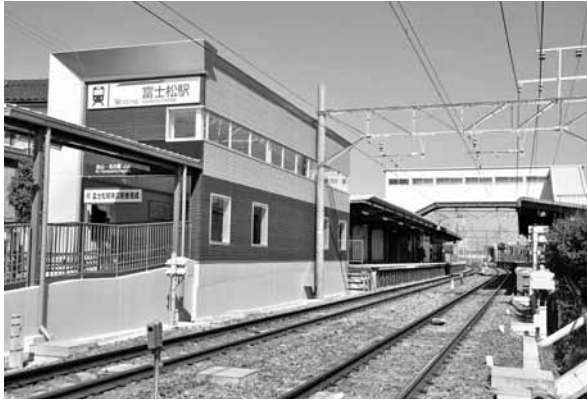
名鉄富士松駅に新設された南口駅舎
