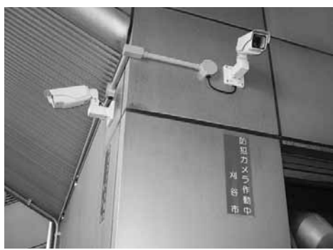
防犯カメラ設置の様子
