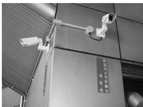
防犯カメラ設置の様子
