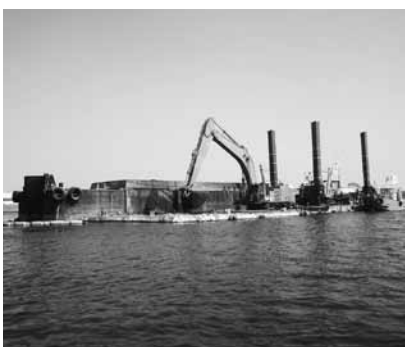
流化能力を高める工事（境川河口）
