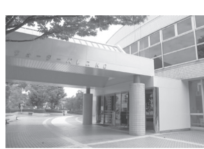
改修予定のウォータパレス
