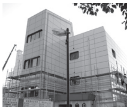
改修中の旧社会教育センター
