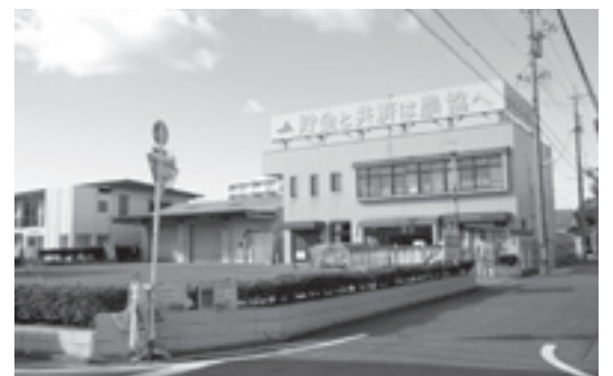
旧 JA 元刈谷支店跡地を防災拠点に活用
