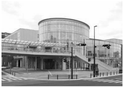
刈谷市総合文化センター エントランス
