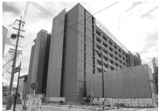
着々と工事の進む刈谷市役所新庁舎
