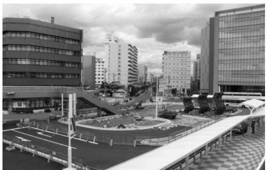
整備中の刈谷駅北口風景
