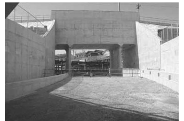
工事中の市道(交通児童遊園前)
