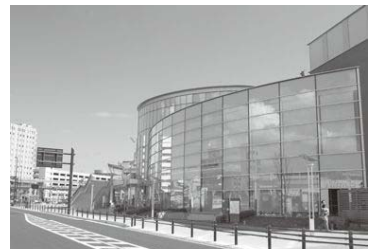
平成22年4月開館予定の総合文化センター
