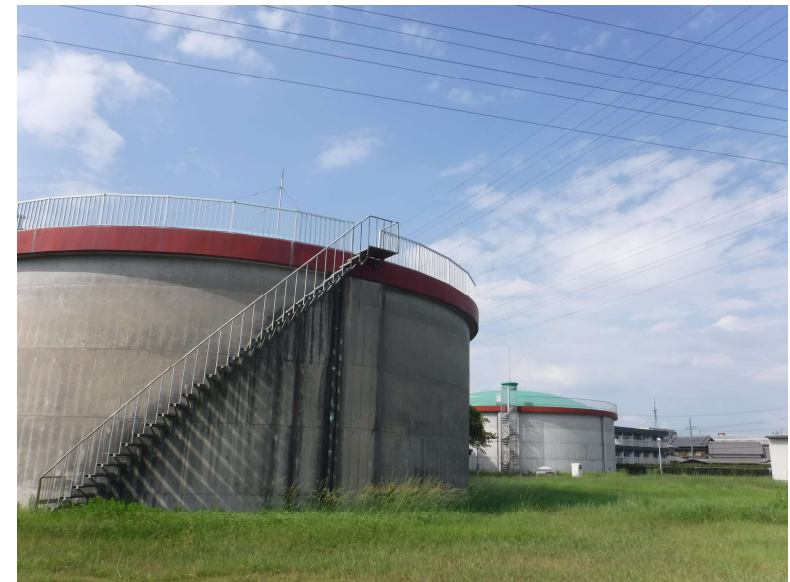
一ツ木配水場 配水池
