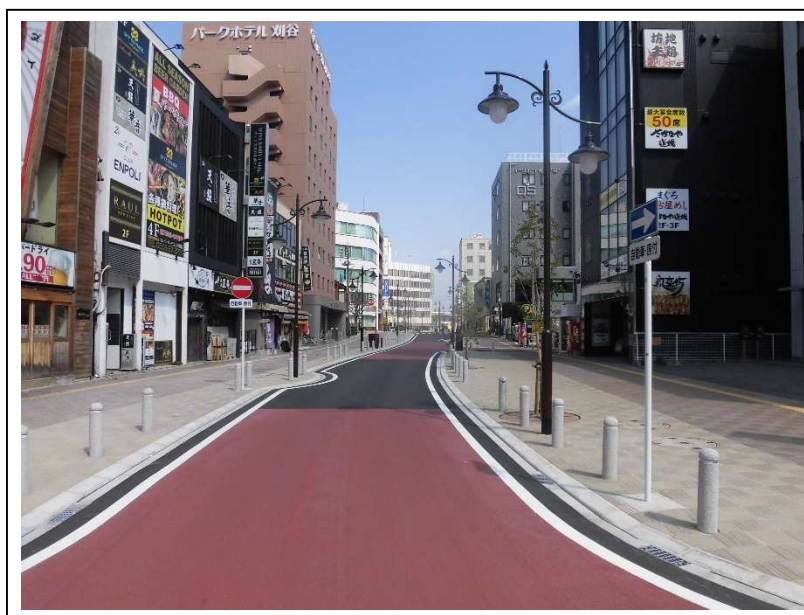
本市における無電柱化整備済み路線例（市道 01-19 号線）
