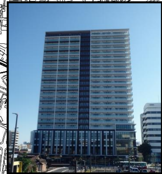
南桜町地区 優良建築物等整備事業
