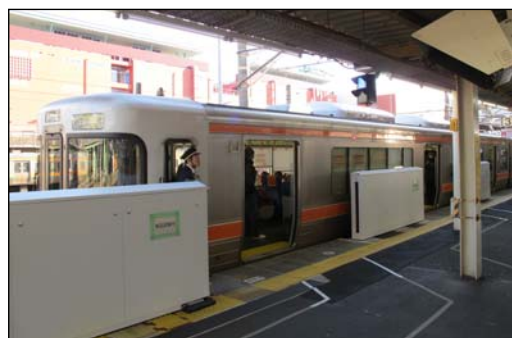
ホームドア(ホーム可動柵) (JR 金山駅 実証試験中)
