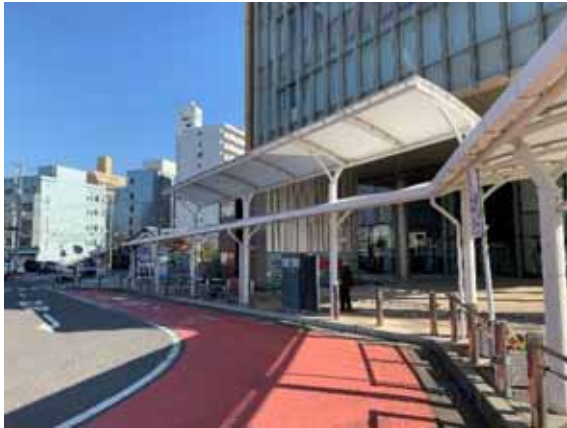
▲刈谷駅北口駅前広場の上屋・ベンチ
