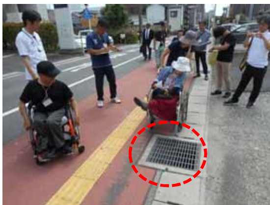
▲幅広のグレーチング
