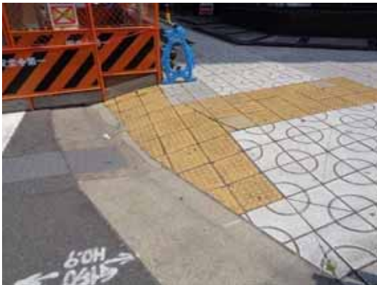
▲市道01-19号線 横断歩道と歩道のすりつけ部(北方向)
