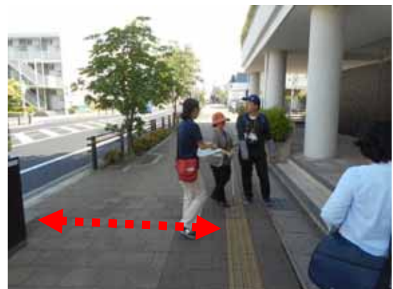
▲総合健康センター前バス停付近の視覚障害者誘導用ブロック
