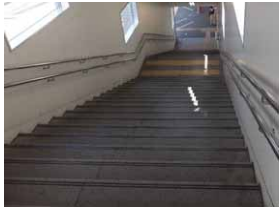
▲階段の段鼻（踏面の先端部）
