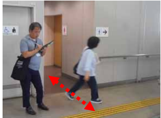
▲視覚障害者誘導用ブロック
