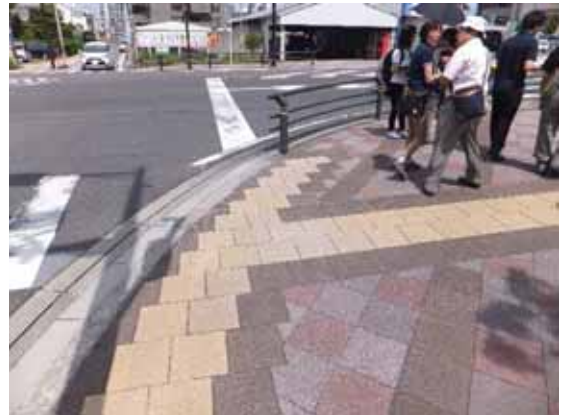
▲視覚障害者誘導用ブロック、エスコートゾーン ▲歩道と横断歩道に段差のないすりつけ部
