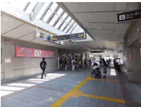
▲視覚障害者誘導用ブロック
