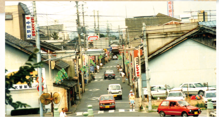
整備前の様子
