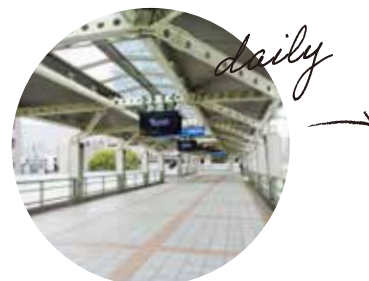
刈谷駅南北連絡通路
