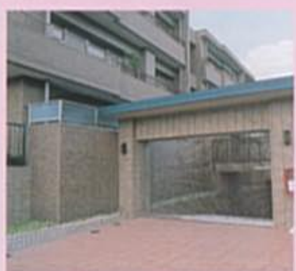
●建物の壁面と同じ仕上げになっています
