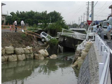
東海豪雨による被害状況（野田町）
