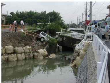
東海豪雨による被害状況（野田町）
