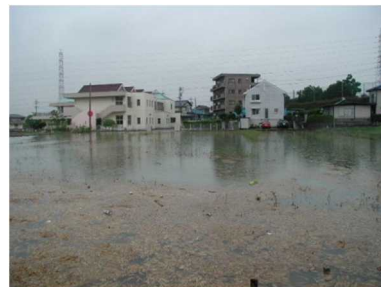
東海豪雨による浸水状況（今川町）
