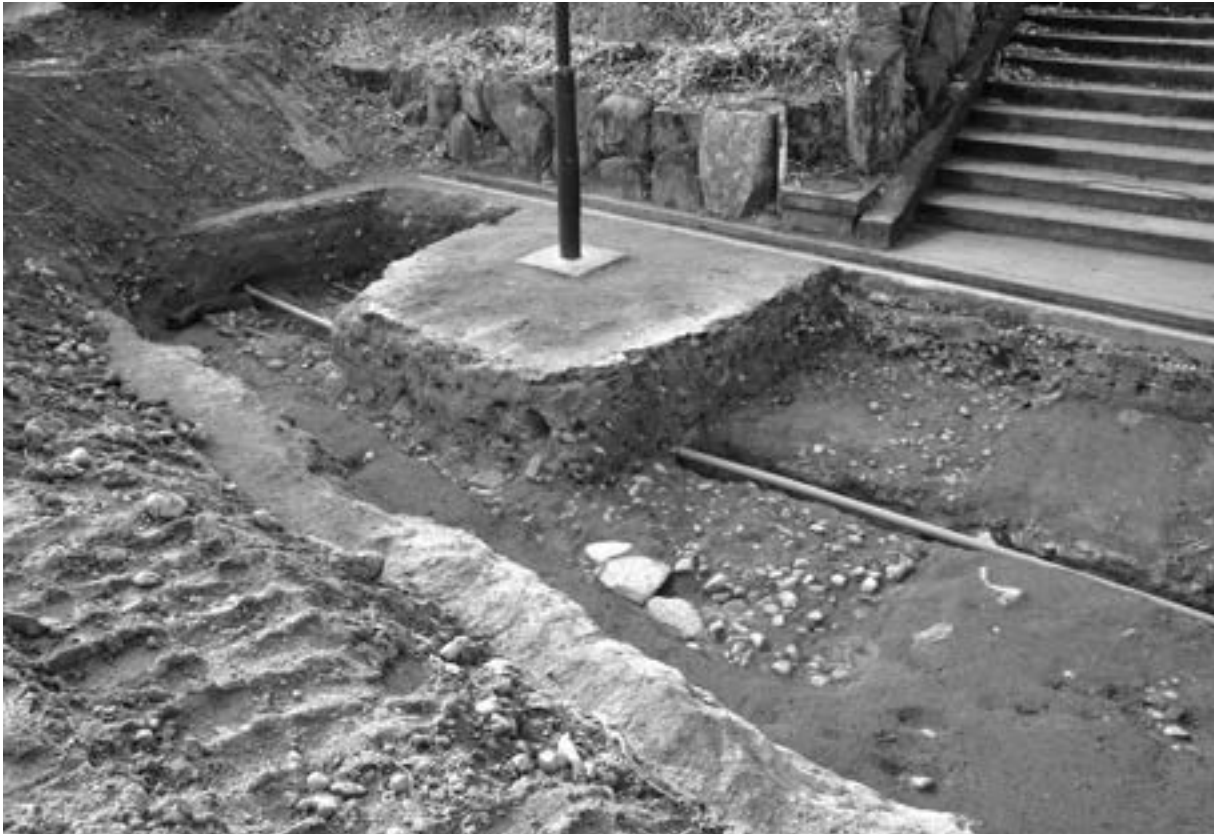
SW 5 外側地固め 検出状況 東から
