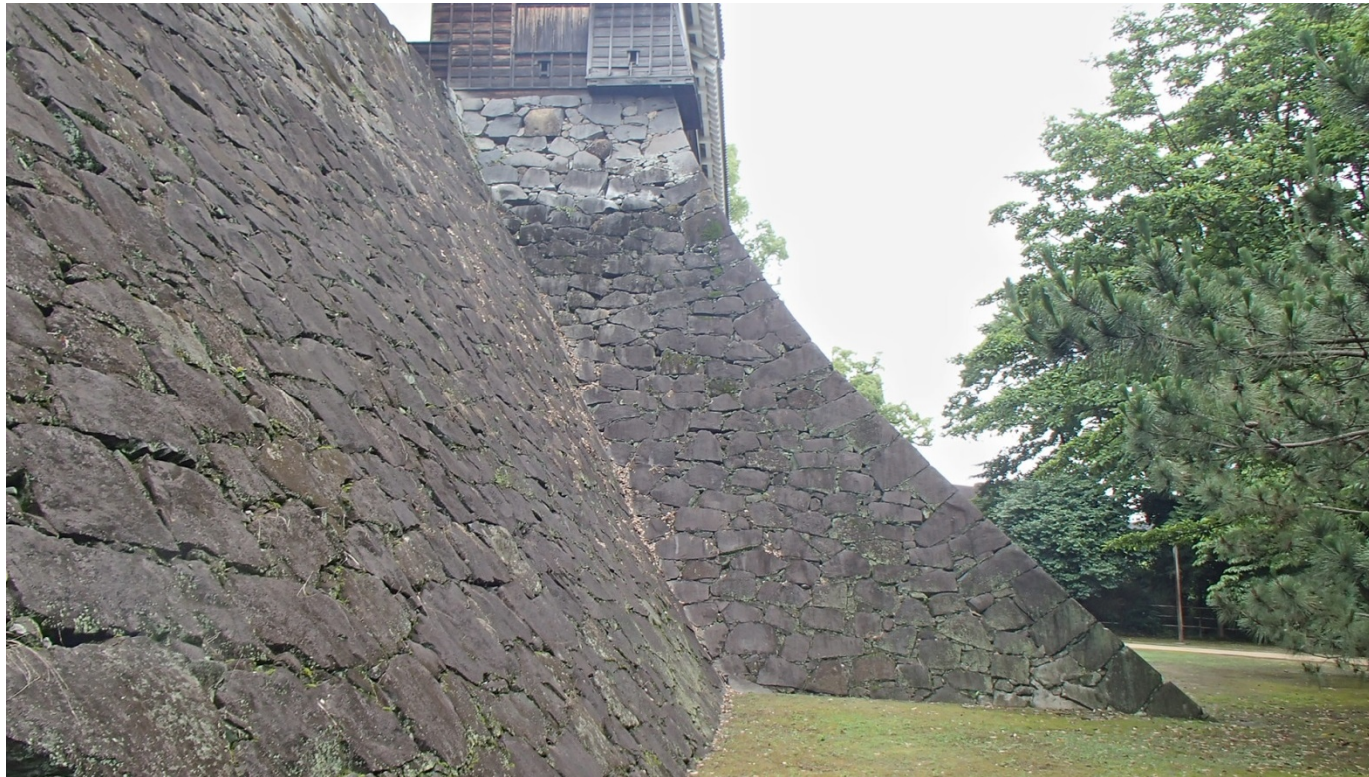
熊本城二之東側丸源之進櫓下石垣
