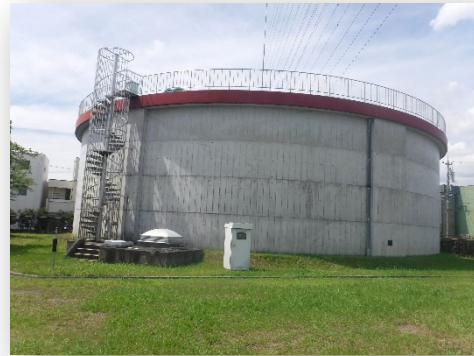
一ツ木配水場 県水 3号配水池
