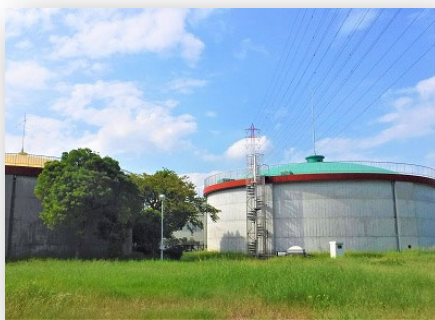
一ツ木配水場 配水池
