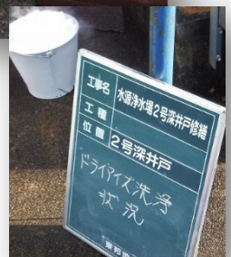
深井戸の洗浄作業の状況 (ドライアイス洗浄)
