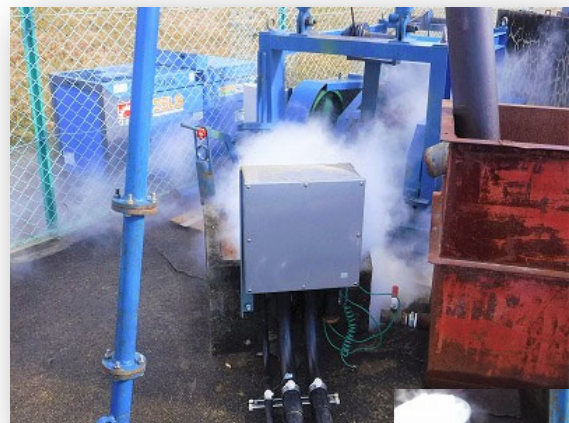
深井戸の洗浄作業の状況 (ドライアイス洗浄)
