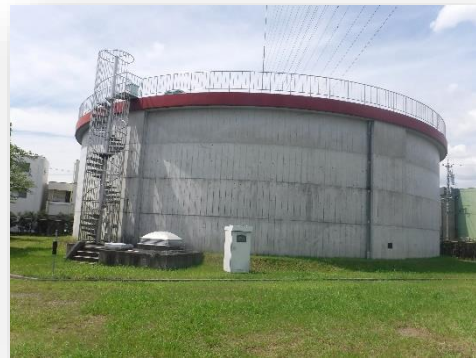
一ツ木配水場 県水 3 号配水池
