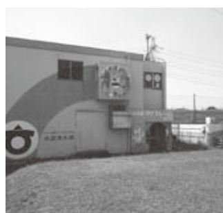
施設更新を予定している水源浄水場
