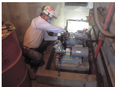
ポンプ場修繕の状況
