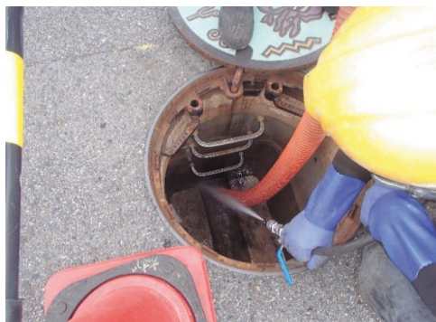
管きよ清掃（高圧洗浄）の状況
