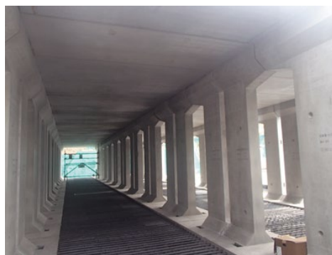
工事中の地下貯留施設の内部
