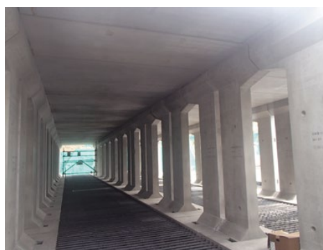
工事中の地下貯留施設の内部
