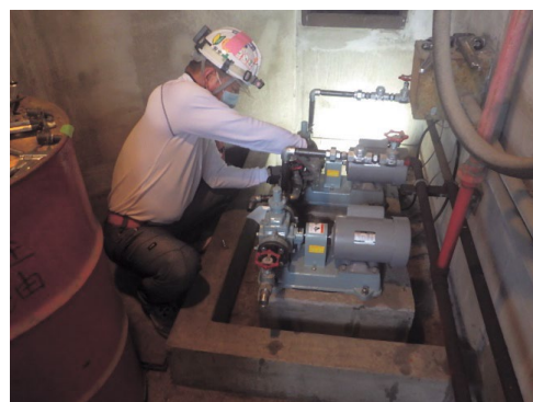
ポンプ場修繕の状況
