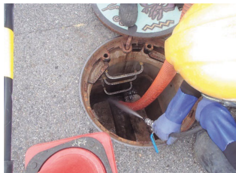
管きよ清掃（高圧洗浄）の状況
