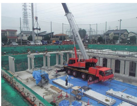
地下貯留施設の設置の様子
