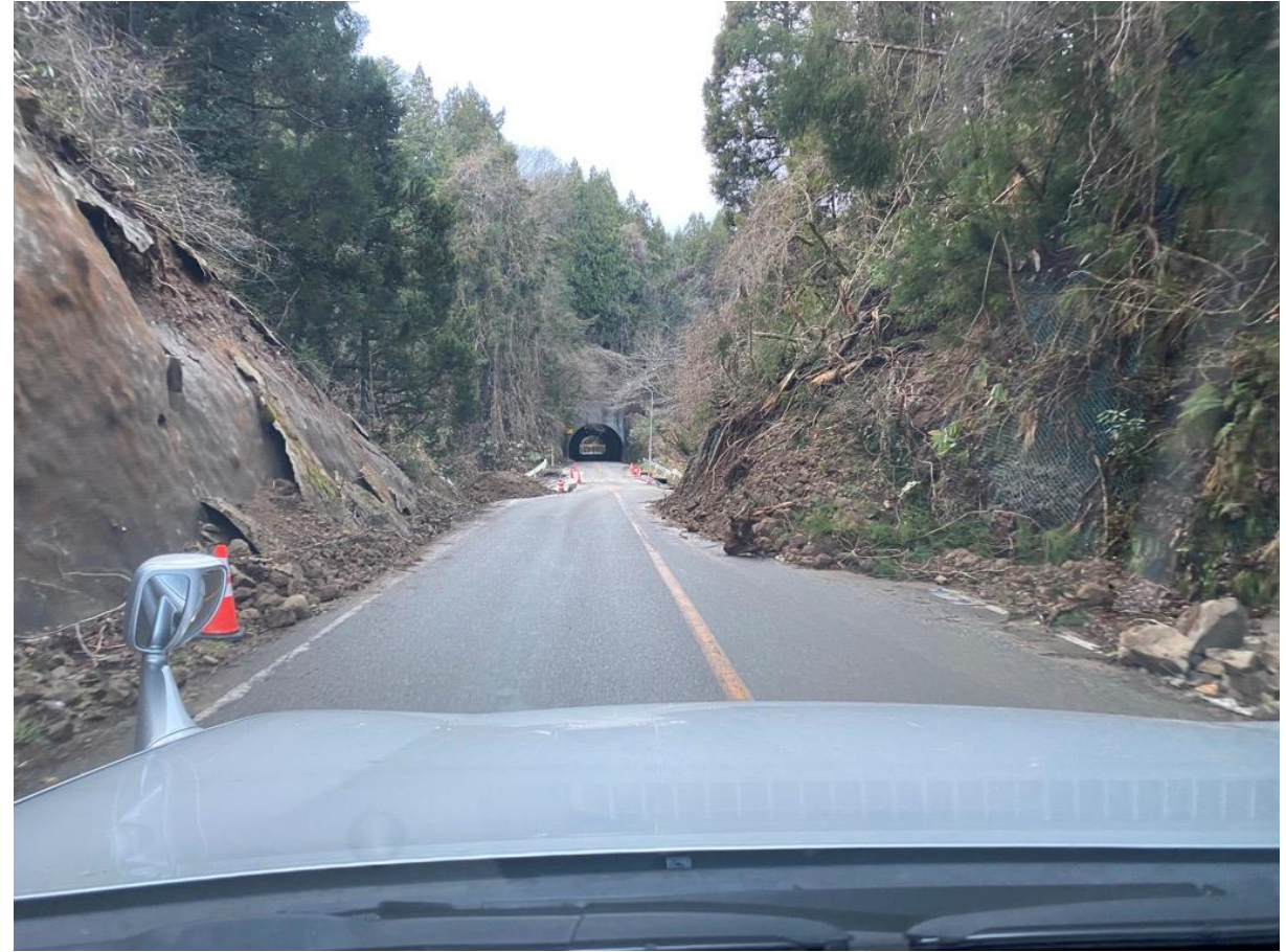
派遣先までの道中② （道路の土砂崩れ）
