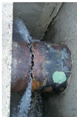
▲水道管の劣化による漏水
