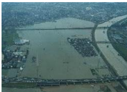
■東海豪雨での被害状況
