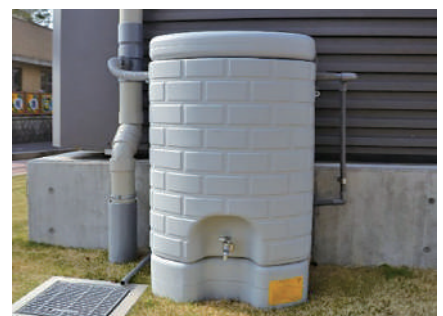
▲雨水貯留施設
