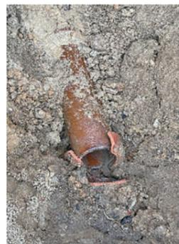
▲下水道管の劣化による破損
